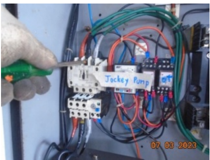
ตรวจสอบจุดต่อสายไฟ Terminal
